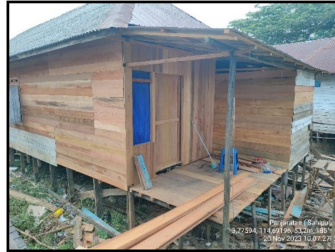
Gambar. Setelah dilakukan rehabilitasi
