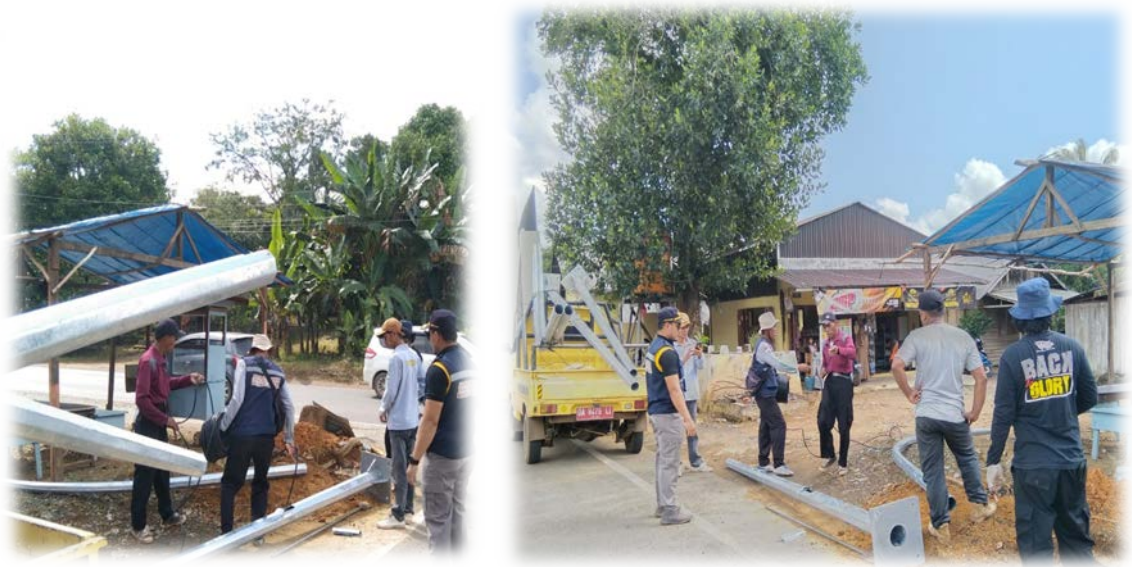
Gambar 3.4 : Kegiatan Pemasangan tiang APJ (Alat Penerangan Jalan)
