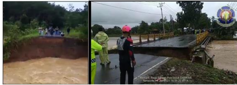
Gambar 3.21 Dampak Bencana Banjir di Kabupaten Tanah Laut, Januari 2021
