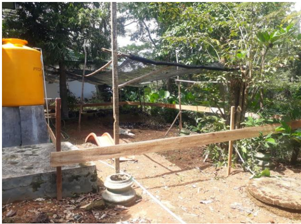
Pemasangan bow plank
