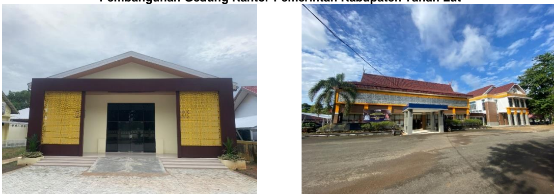
Gambar 3.6 Pembangunan Gedung Kantor Pemerintah Kabupaten Tanah Lut
