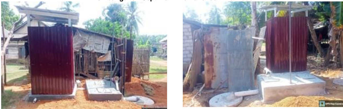
Gambar 3.4 Pembangunan Septi Tank Komunal dan Individual
