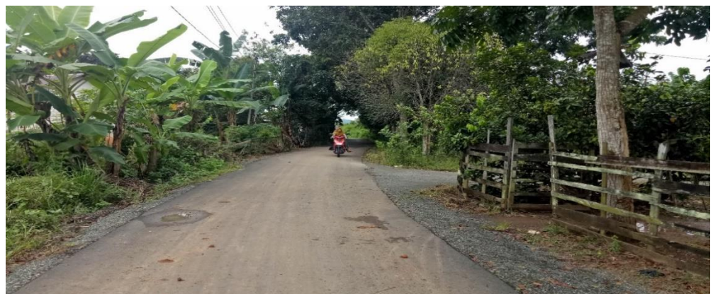
Paket Pekerjaan Rehabilitasi Jalan Bati-Bati Ujung (SDN) (Ruas No. 217) dengan volume rencana 122 M'
