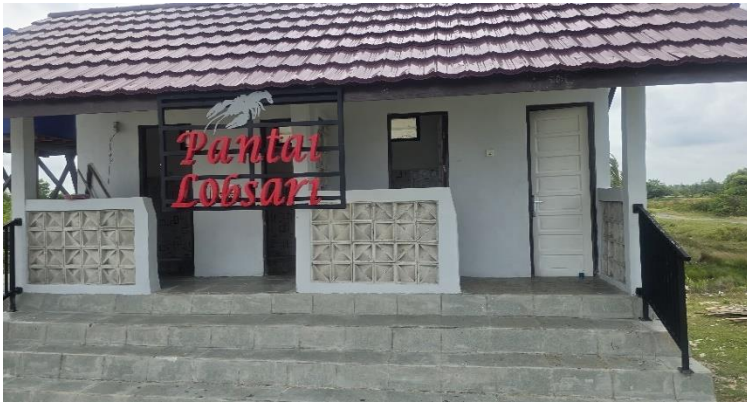
Kegiatan Pembangunan Toilet
