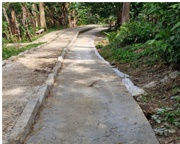
Kegiatan Rehabilitasi Jalan Setapak
