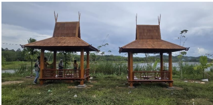
Kegiatan Pembangunan Gazebo
