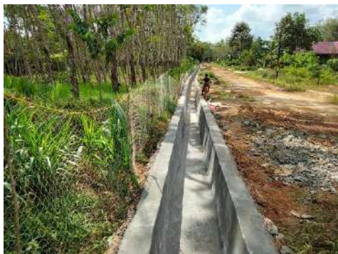
Gambar 3.20 Pembangunan Drainase Desa Batu Ampar Desa Pantai Linuh
