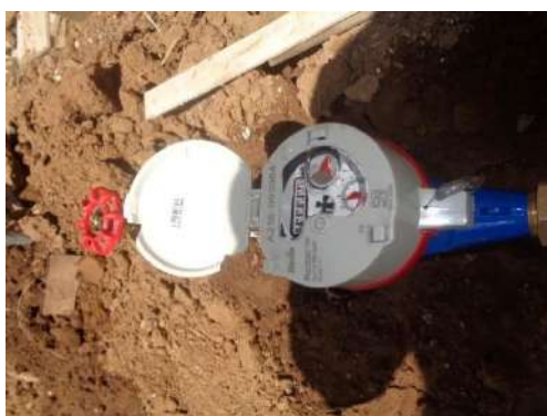
Gambar 3.21 Pembangunan Sambungan Rumah Desa Ranggung Desa Benua Tengah
