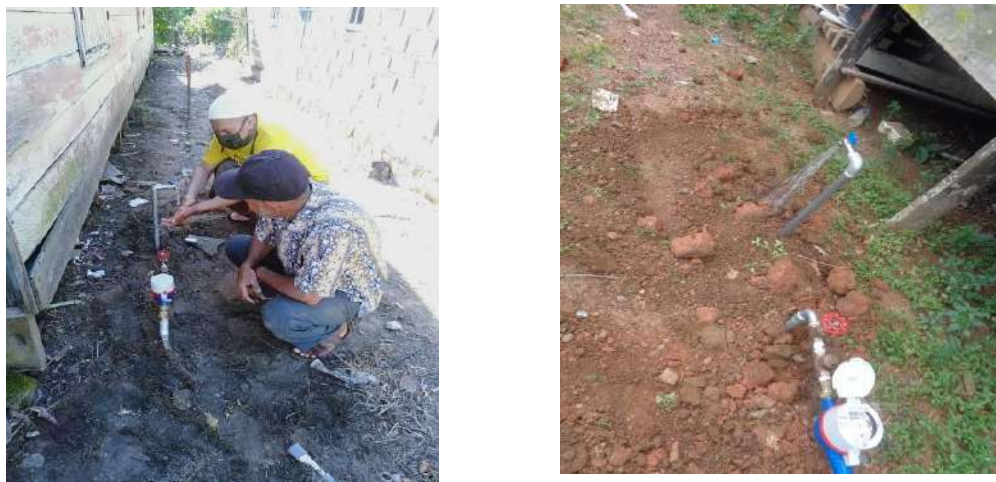
Gambar 3.22 Pemasangan Sambungan Rumah Desa Bentok Kampung dan Batu Tungku
