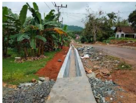
Gambar 3.20 Pembangunan Drainase Desa Batu Ampar Desa Pantai Linuh
